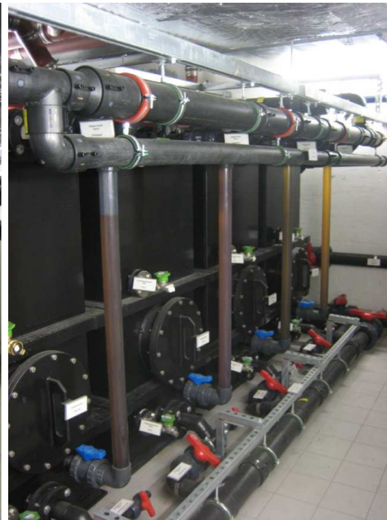
PE urine storage tanks (4 x 2500 L)
