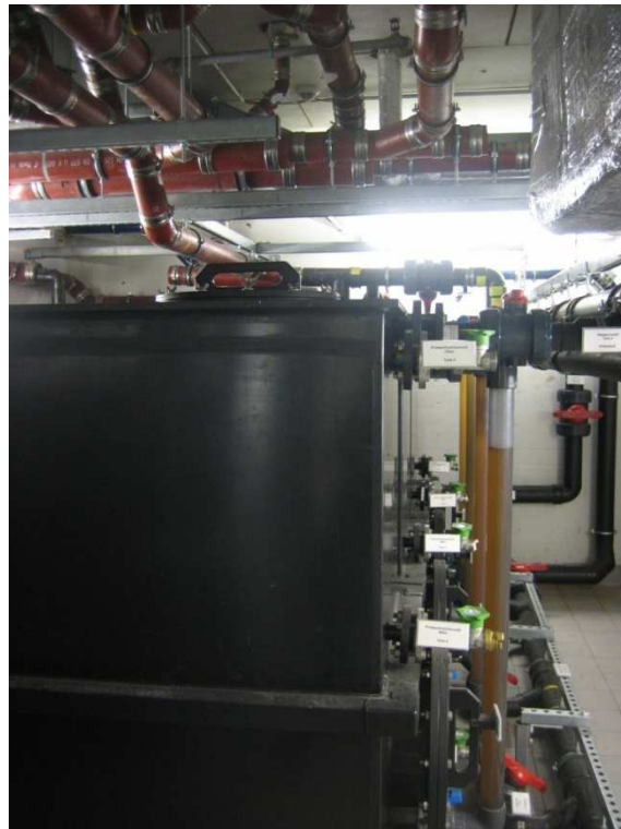
PE urine storage tanks (4 x 2500 L)
