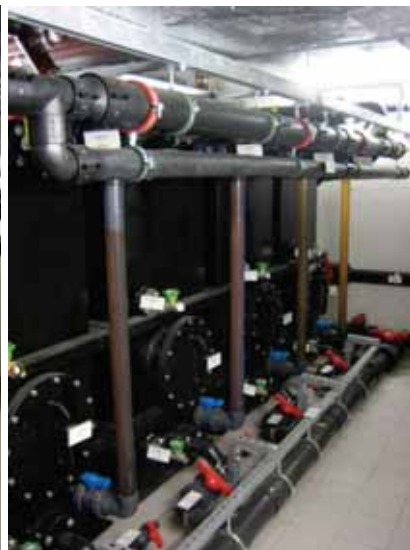
PE urine storage tanks (4 x 2500 L)
