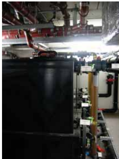
PE urine storage tanks (4 x 2500 L)
