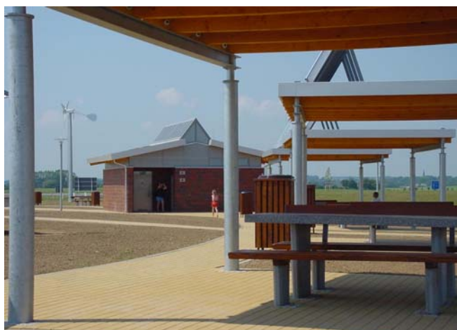
Figura 7: vista desde las pérgolas al sanitario solar
