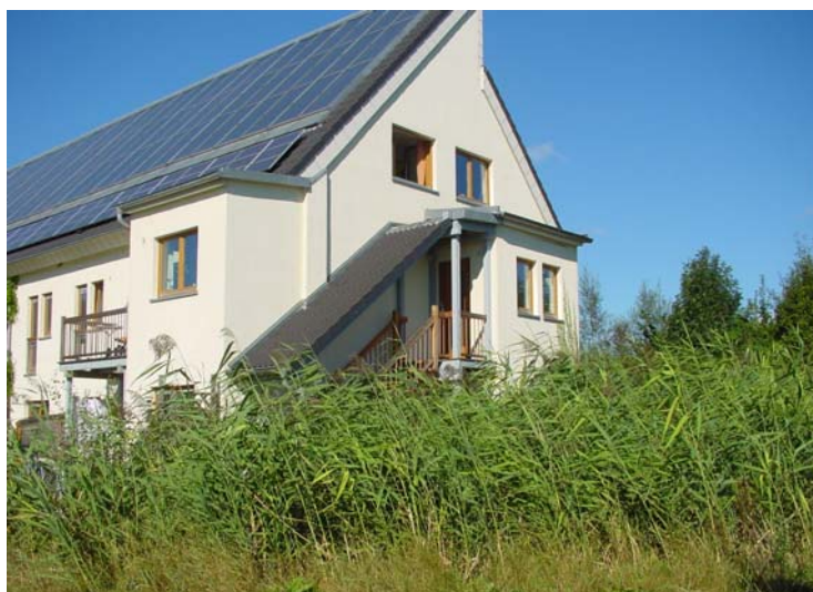
Figura 3: Vista de la cama de juncos de subterra y la casa equipada con paneles solares
