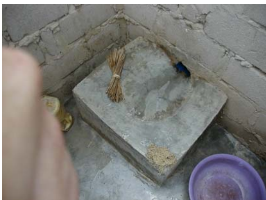
Figura 3: Las letrinas secas de Luanda se han convertido para utilizar agua para arrastre y están impresionantemente limpias
