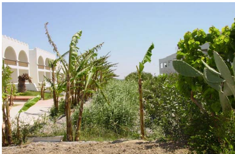
Figura 5: Vista de la cama de juncos subterra junto a los apartamentos
