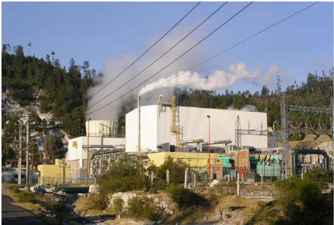
Ilustración 10. Planta Geotérmica: Los Azufres, Michoacán
