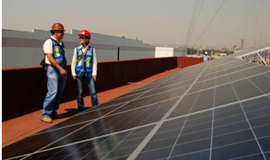
Ilustración 6. Sistema fotovoltaico conectado a la red eléctrica
