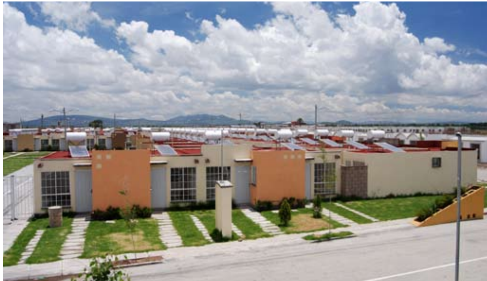
Ilustración 12. Aplicación de calentadores solares de agua en desarrollo residencial
