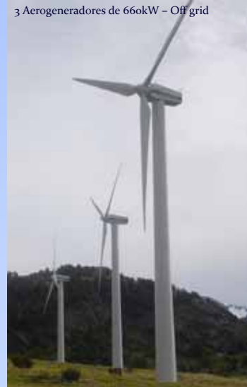
3 Aerogeneradores de 660kW – Off grid
