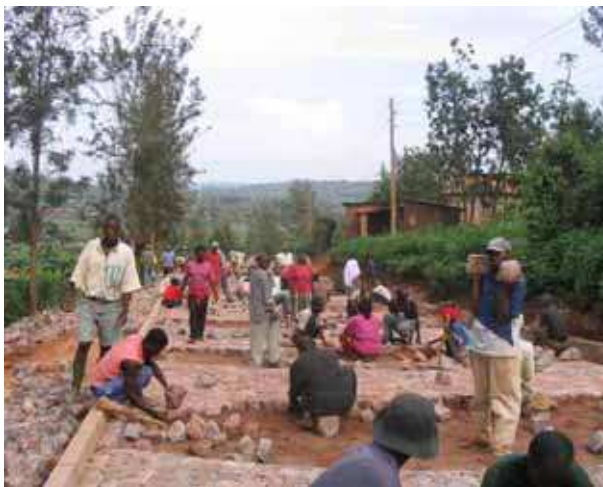
Abb.3: Bau einer Natursteinpflasterstrasse in Kigali
