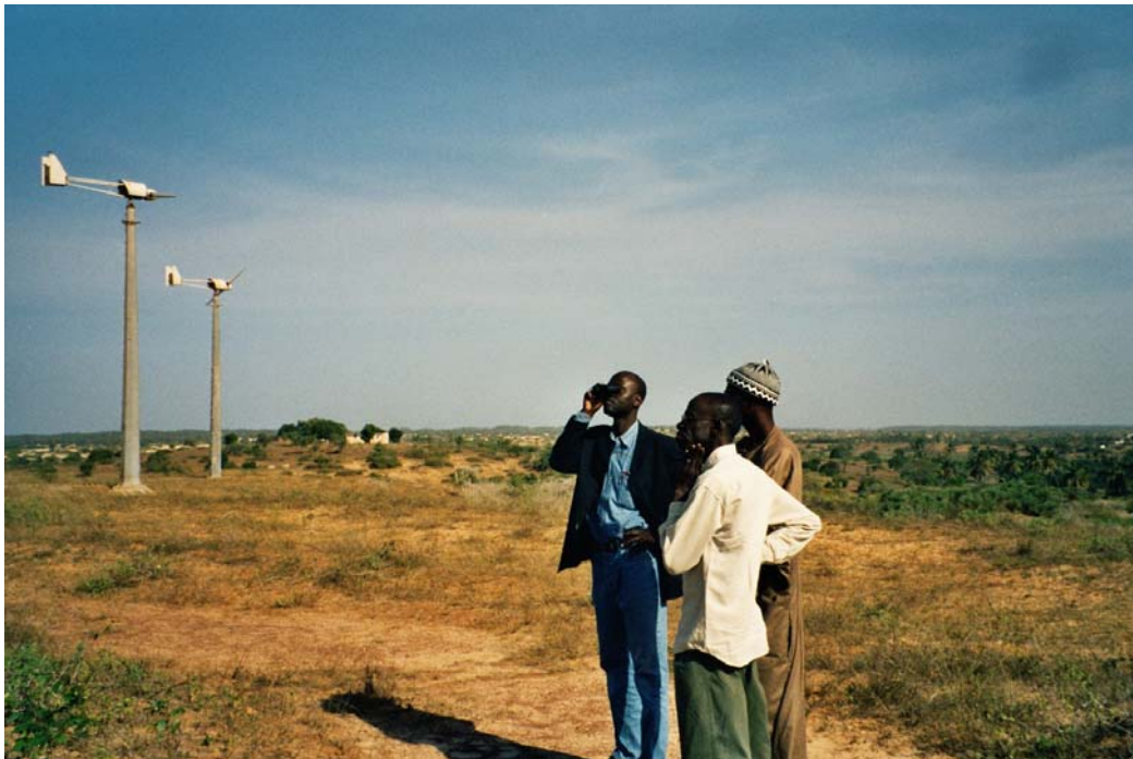
Abb. 4.4: Windpark in Mboro mit 10 WEA, die zwischen 1991 und 1995 in einem Inselnetz zur Bewässerung in Betrieb waren.
