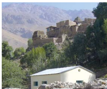
Kleinwasserkraftwerk in Sangab Foto: GTZ
