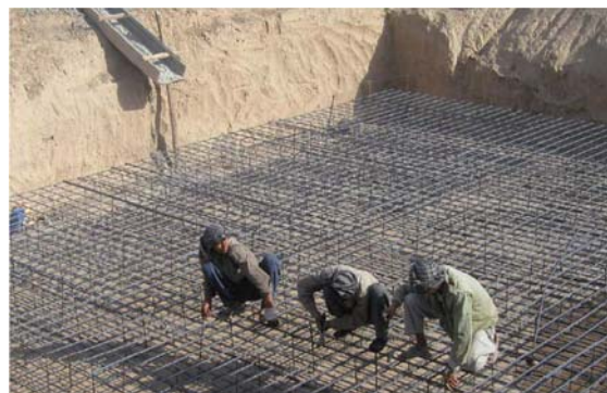
Bewehren der Stahlbeton-Bodenplatte | Foto: GTZ
