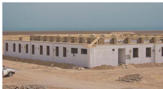
Errichten des Dachstuhls | Foto: GTZ
