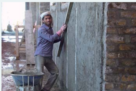
Die Wände werden glatt verputzt | Foto: GTZ
